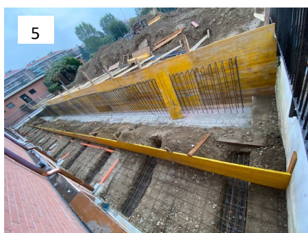
5 PANORAMICA TRAVI E MURO
