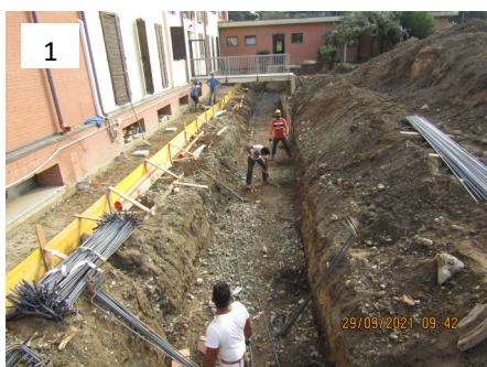
1 INIZIO POSA FERRI
