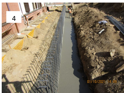
4 COPERTURA CON CEMENTO
