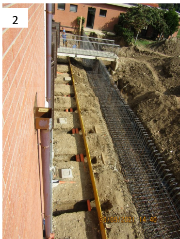
2 1° STRATO ARMATURA FERRO
